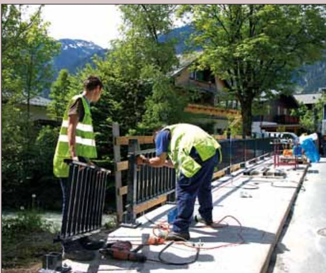
*Das alte Geländer an der Traunsteinerbrücke war bereits desolat und musste erneuert werden. Die Stadt beauftragte daher eine Spezialfirma mit der Errichtung eines neuen Geländers. Dieses wurde kürzlich montiert, womit auch die Sicherheit für die Fußgänger wieder gewährleistet ist.*
