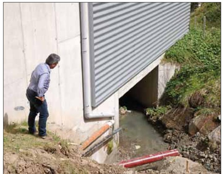
*Die Wasserfassung vom Griesalmbach erfolgt mittels Rohr unter dem Betriebsgebäude des Ehrenbachhöhe-Lifts.*
