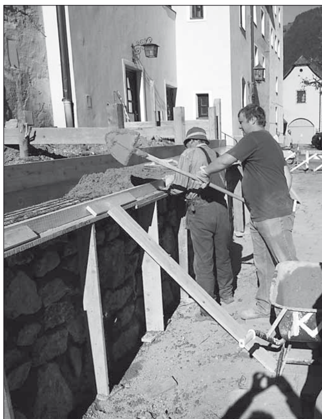
Die ruhige Zeit in der Zwischensaison wird zumeist dahingehend genutzt, dringend nötige Sanierungsarbeiten im städtischen Bereich umzusetzen. Im Bild oben zu sehen sind Ausbesserungsarbeiten bei der Straßenpflasterung in der Innenstadt. Derzeit ist ein Konzept für die ebenfalls anstehende Sanierung der Fußgängerzone in der oberen Vorder- und Hinterstadt in Ausarbeitung. Das Bild unten zeigt Arbeiter bei der Neuerrichtung der desolaten Mauer im Bereich des ehemaligen Skischulbüros.
