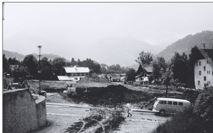
Aushubarbeiten Ende Mai 1964.
