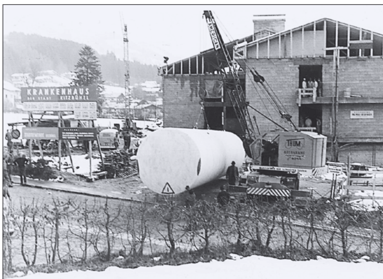
Der Rohbau kurz nach der Firstfeier im November 1964.
