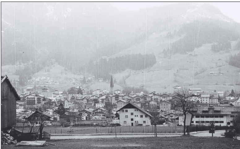
Blick von der Sonnseite auf die Stadt knapp vor Baubeginn des neuen Krankenhauses.
