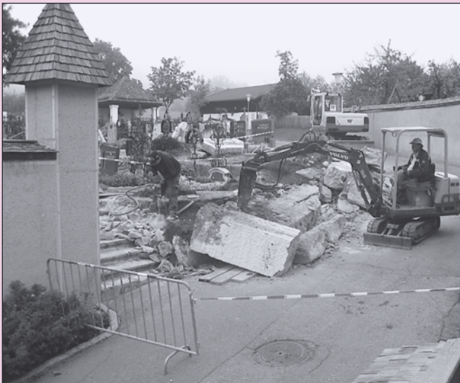
Die vor Jahrzehnten errichtete Mauer beim neuen Friedhof wurde kürzlich abgerissen und durch eine neue ersetzt. Der Zahn der Zeit und vor allem die Witterungseinflüsse hatten an dem Mauerwerk bereits arg genagt, wodurch die Erneuerung nötig wurde. Die Grabsteine, welche sich in unmittelbarer Mauernähe befanden, mussten im Zuge der Bauarbeiten entfernt werden. Sie werden demnächst wieder fachmännisch an ihrem angestammten Platz aufgestellt werden.
